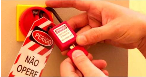
Figura 6: Etiqueta e cadeado para bloqueio de ligamento. Fonte: Internet.
